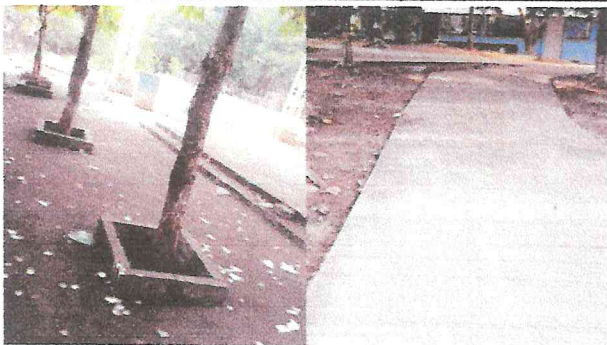
Foto 5: Planchas de concreto en patio
