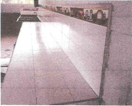
Foto 1: Azulejo instalado en la cocina
