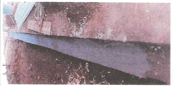
Foto 4: Banqueta de concreto
